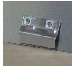
Glashalteklammer montiert
