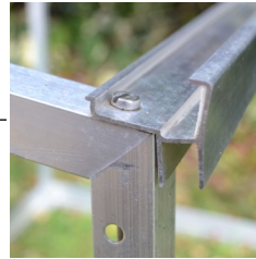
BEFESTIGUNG TRAUFPROFIL
