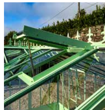
Dachfenster mit Teleskop-Spindel
